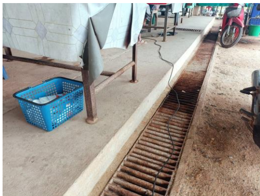
มีรางระบายน้ำเสียและมีตระแกรงเหล็กปิด
