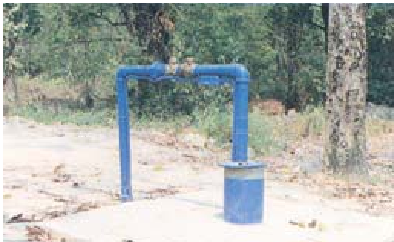
รูปที่ 7 บ่อน้ำบาดาลที่ใช้เป็นแหล่งน้ำดิบ
