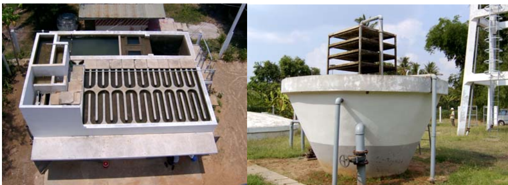
รูปที่ 25-26 ถังกรองน้ำ
