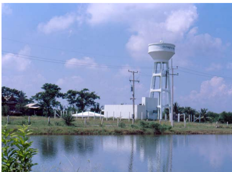
รูปที่ 8 แหล่งน้ำผิวดินและระบบน้ำสะอาดแบบผิวดิน
